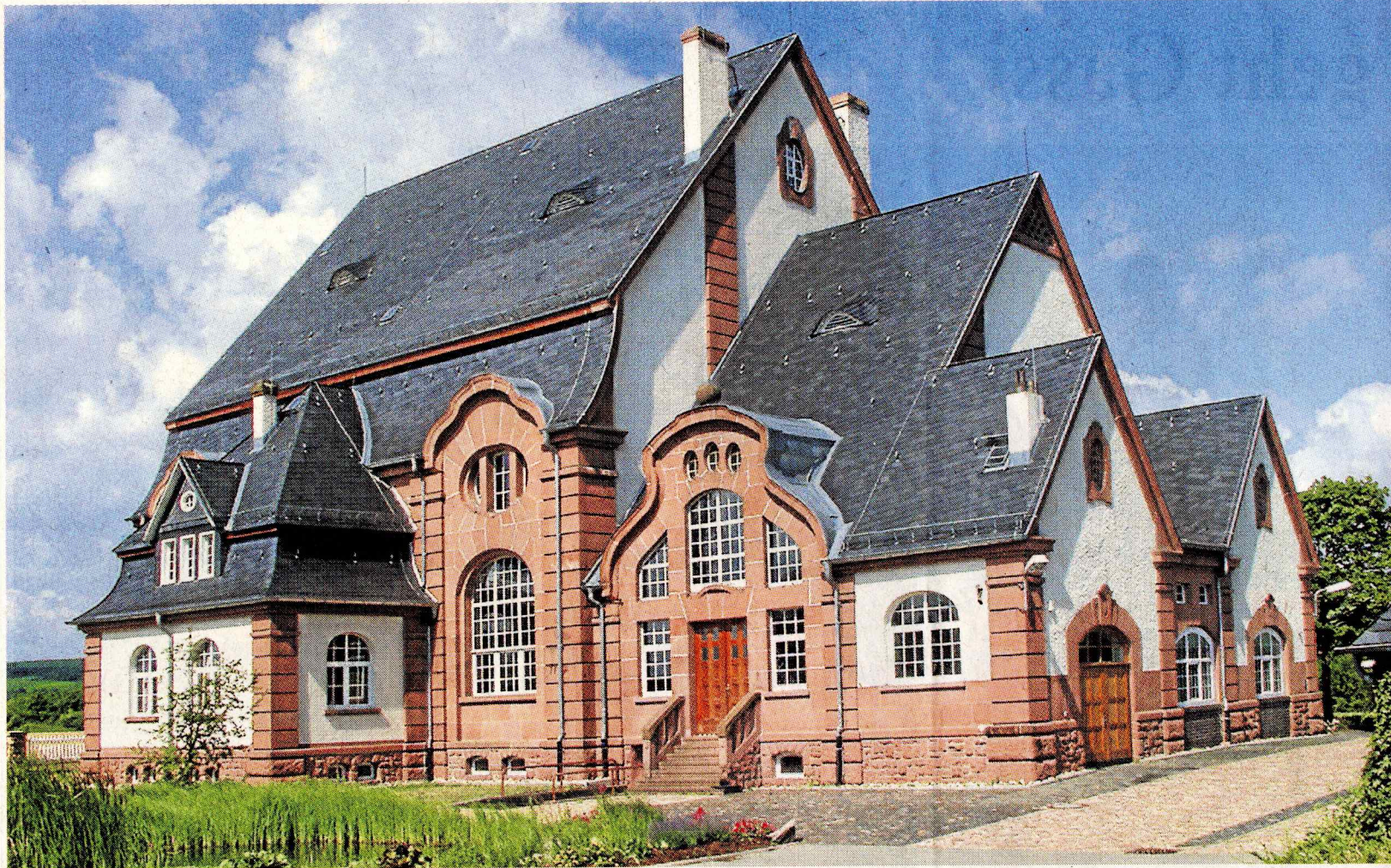
Das alte Pumpwerk in Guntersblum steht für die Historie der über 100 Jahre alten Wasserversorgung.
